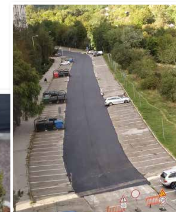
Zrekonštruovali sme 850 m² cesty na Wuppertálskej ulici
